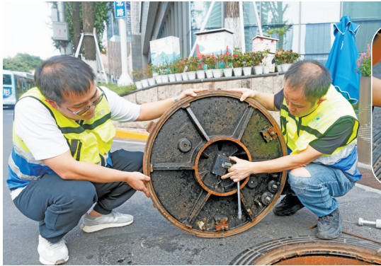
▲10月16日，市政工作人员打开智能井盖，查看其背部的智能密码锁、机械密码锁和传感器等装置。
