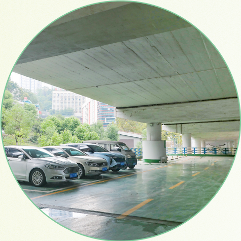
溉澜溪大桥下停车场,车辆整齐停放。
